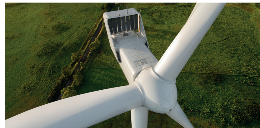
Anlagentyp: Vestas V126, Nennleistung je Anlage 3.300 kW, Nabenhöhe 137m
